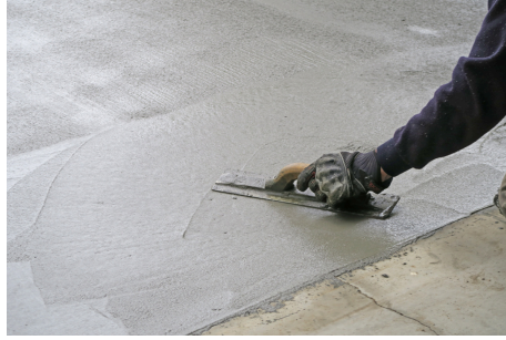
ARA KAT DÖŞEME
